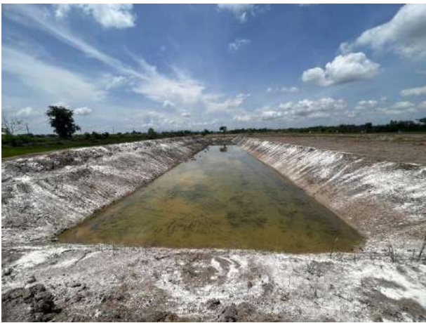
ภาพที่ ๔ บ่อดักตะกอน ต.ดอนยอ อ.เมือง จ.นครนายก
