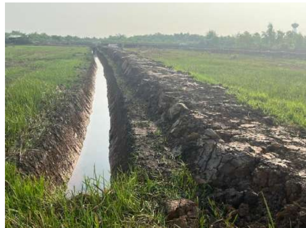
ภาพที่ ๓ ขุดคูระบายน้ำ/ขุดลอกคูระบายน้ำ (ลักษณะที่ ๒) ต.ดอนยอ อ.เมือง จ.นครนายก
