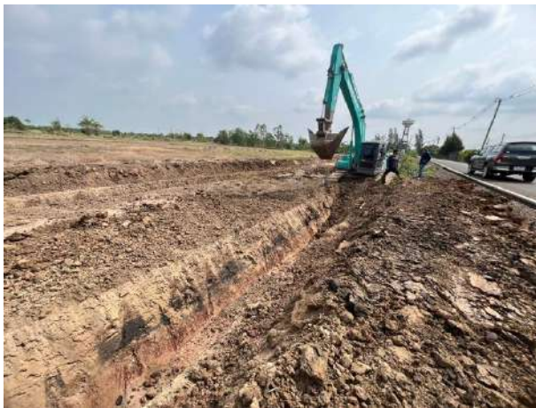
ภาพที่ ๓ ขุดคูระบายน้ำ/ขุดลอกคูระบายน้ำ (ลักษณะที่ ๒) ต.ดอนยอ อ.เมือง จ.นครนายก
